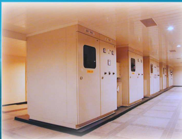
高壓變電站工程
