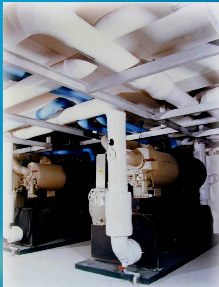
空調主機配管工程
