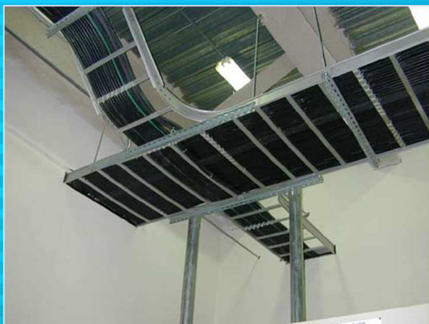
電力橋架工程(1)
