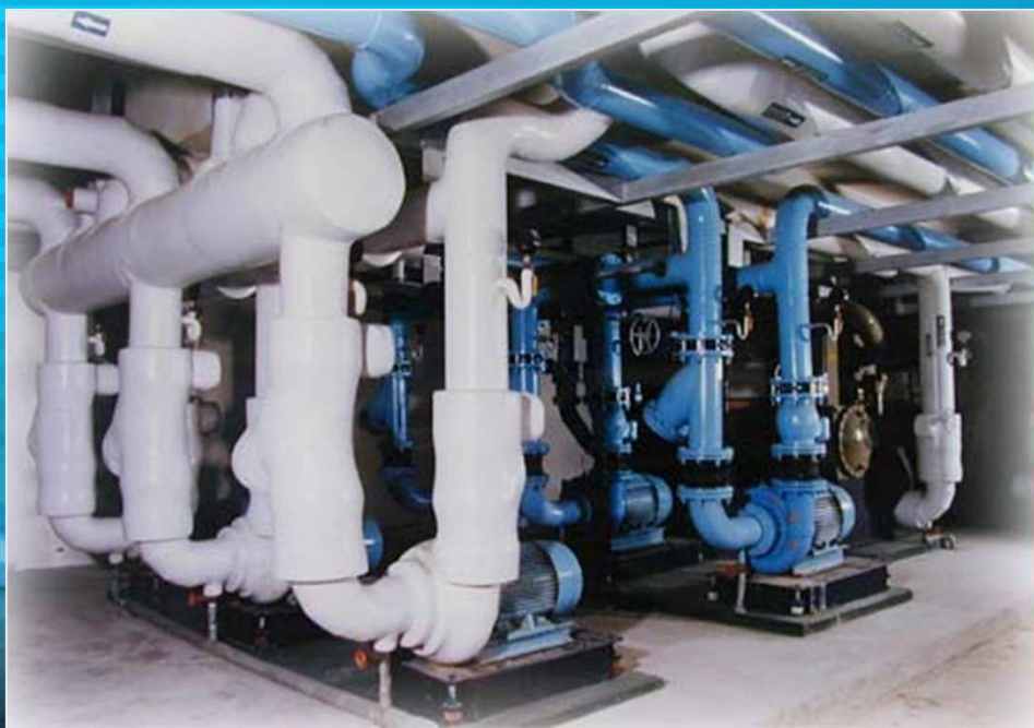
空調配管工程
