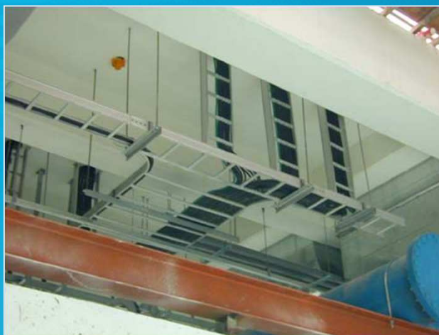
電力橋架工程(2)
