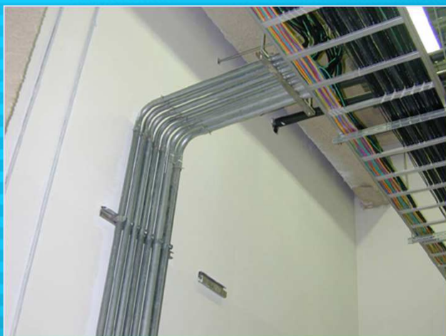
動力配管工程(1)
