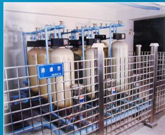
過濾系統工程
