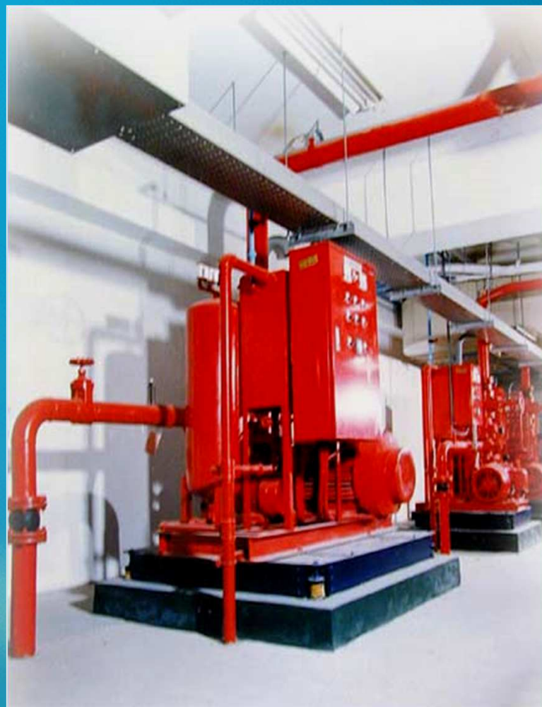
消防泵浦配管工程
