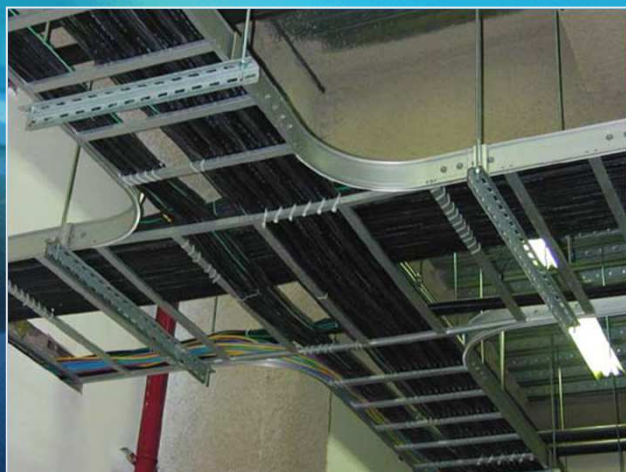
電力橋架工程(3)
